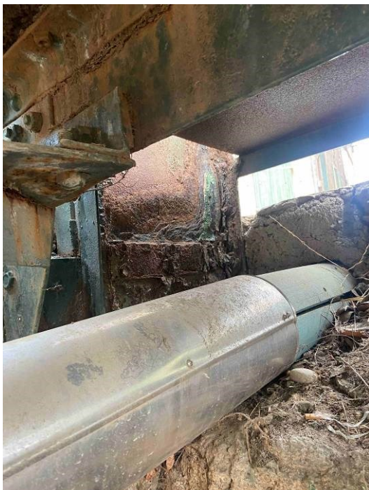
Appui rive gauche amont
