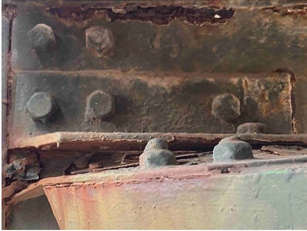
Corrosion perforante avec perte matière sur profilé
