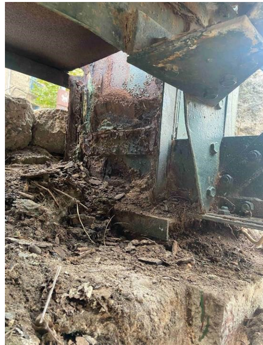
Appui rive gauche aval
