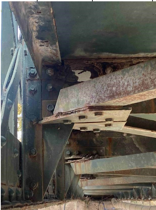
Corrosion perforante avec perte matière sur profilé
