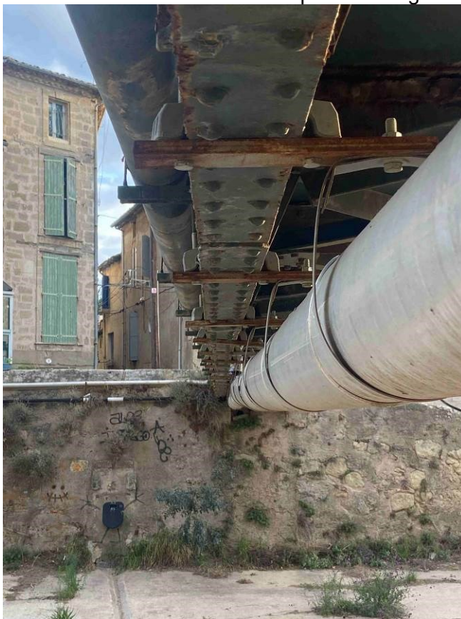
Déformation sous contrainte du profil en long de l'ouvrage
