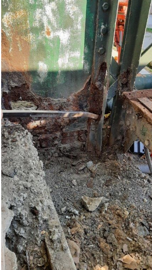
Appui rive droite amont
