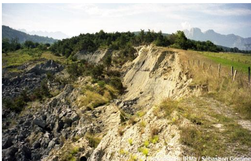
Glissement de terrain (source : irma)
