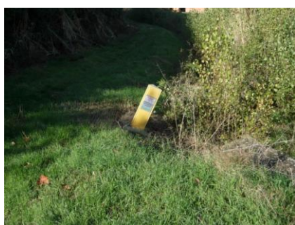
Bornes témoins de canalisation de gaz
