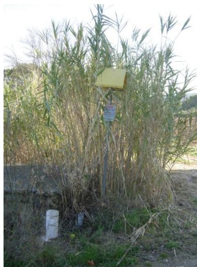
Bornes témoins de canalisation de gaz
